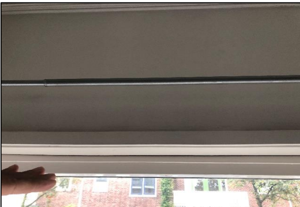
3. Doorbuiging in aftimmerlat geconstateerd. Advies: corrigeren van aftimmerlat, esthetisch herstel, PM.
