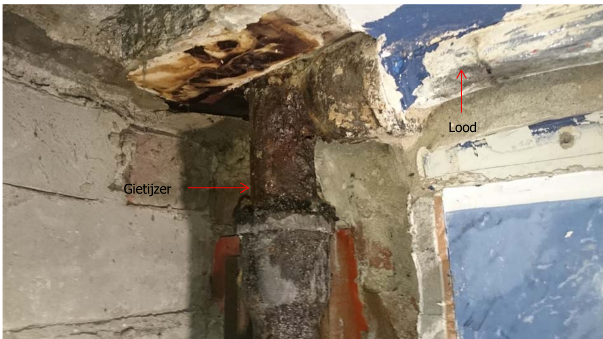
Foto 6: Riolering in gietijzer en lood
