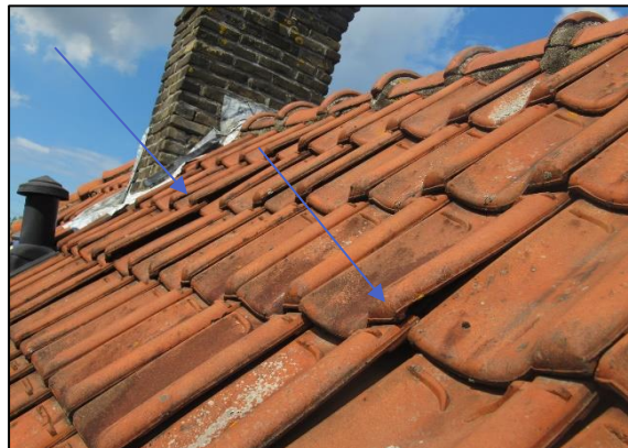
10. Open panverbinding zichtbaar.
