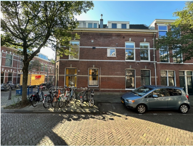
Geveloverzicht – rechter zijgevel
