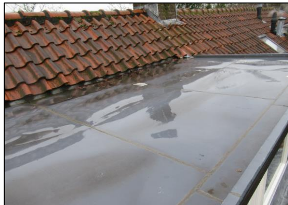
6. Plat dakafwerking dakkepel achterzijde.
